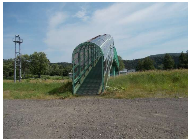
屋根付きの陸橋を見れば雪深さがわかる。
